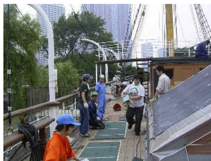
写真 5：防水アスファルトシートを貼る。
