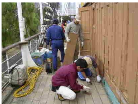
写真 4：木部の補修作業。
