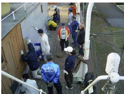
写真 6：防水塗装の作業。
